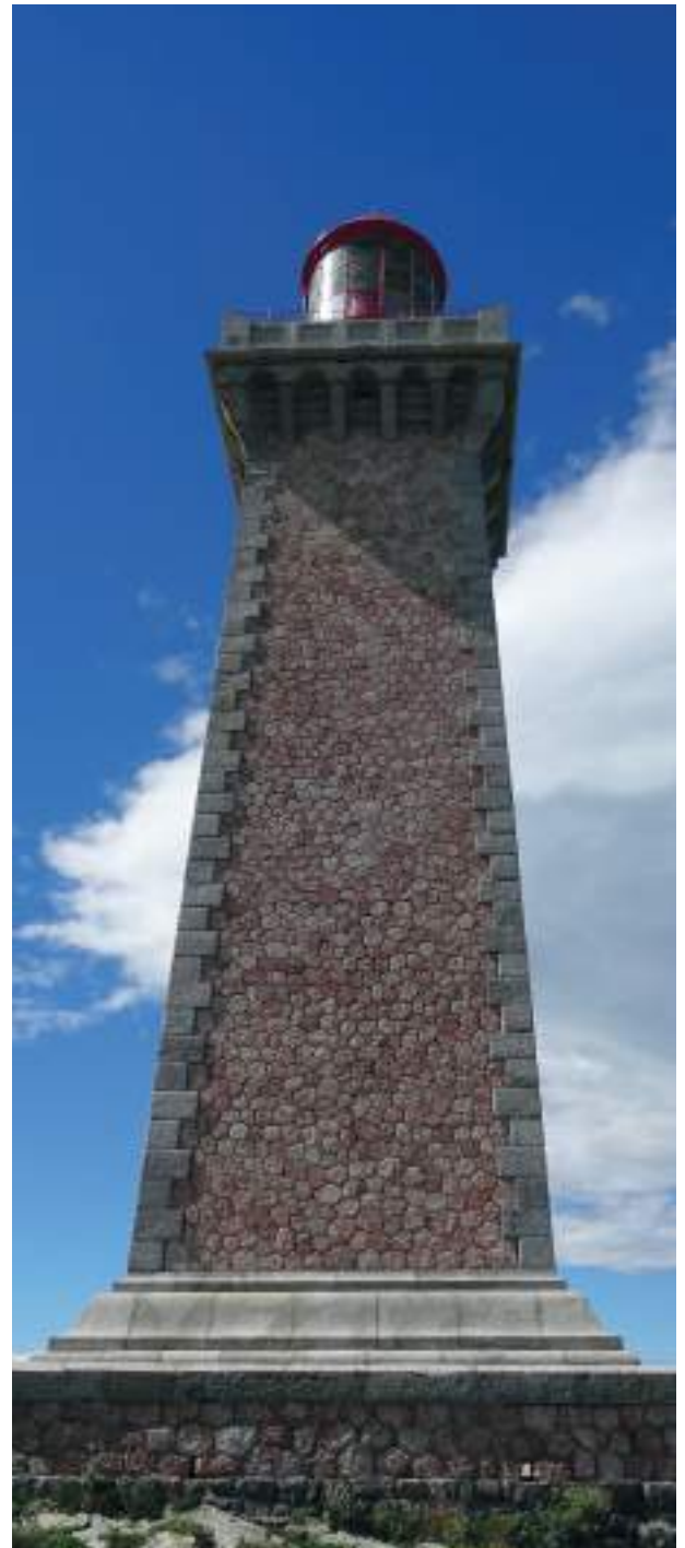
2- Élévation Nord Ouest, la façade du phare est identique à celle opposée, elles sont constituées d'entourage en granite et de remplissage en marbre
