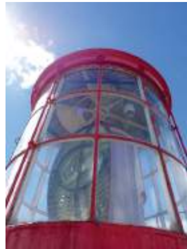
2- Vue sur la lanterne, évacuation des eaux par des exutoires en tête de lions et descente d'eau
