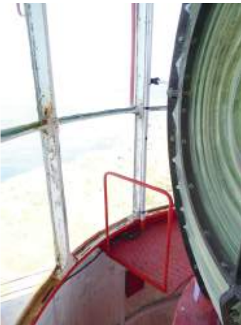
3- - Vue sur le sol de la coursive en tôle larmée peinte
