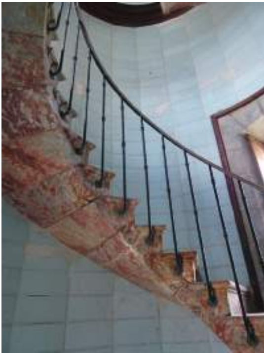
1- Escalier hélicoïdale à vide central en marbre et garde-corps en fonte et cuivre. Parement intérieur en carreaux d'opaline
