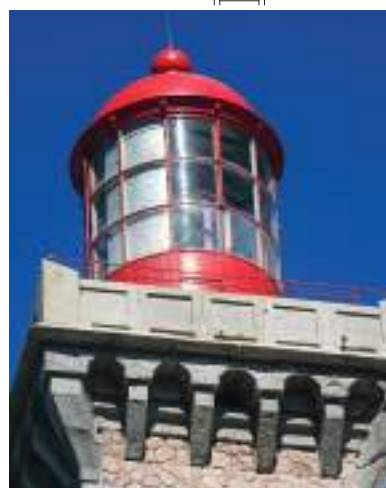
Détail de la lanterne en fer peint et vitrage cintré
