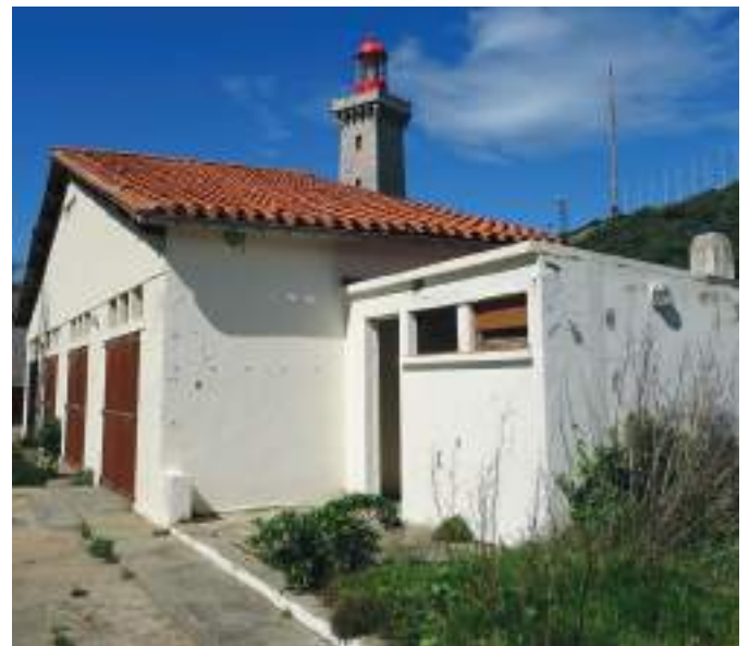
4- Extension Sud, peu qualitatif aussi, perturbe également le bâtiment
