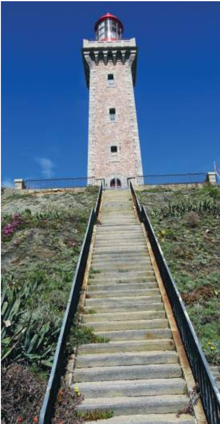
1- Élévation Sud Est. Façade principal du phare faisant face au talus, et tournant le dos à la mer. Accès par un emmarchement en granite et garde-corps en fer riveté
