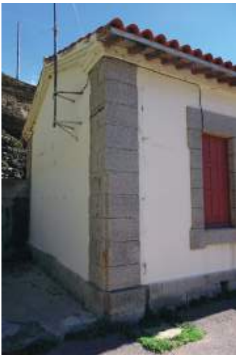
3- Élévation Nord-Est - façade aveugle
