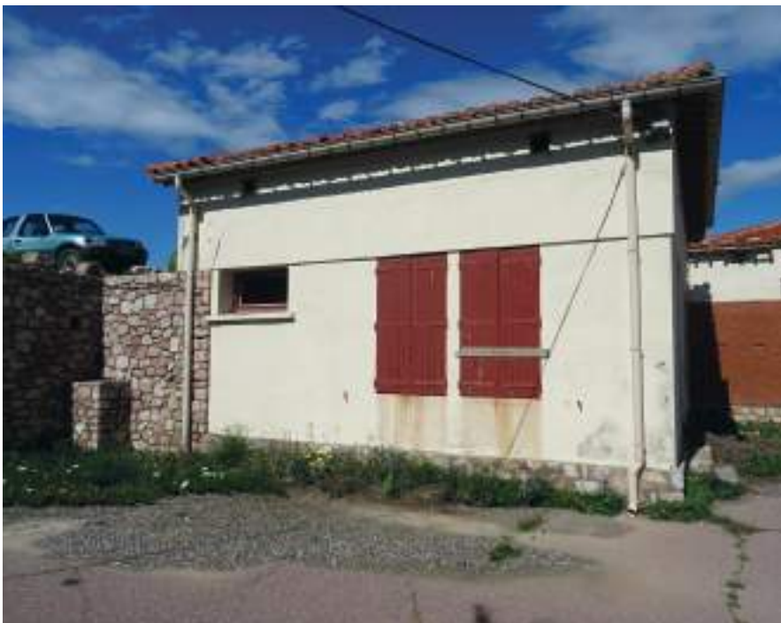
2- Façade Sud Est. Cette élévation est directement visible depuis l'entrée au site. On observe le lien entre le mur de clôture en marbre qui devient un mur de soutènement de la route et qui se lie à l'édifice.
