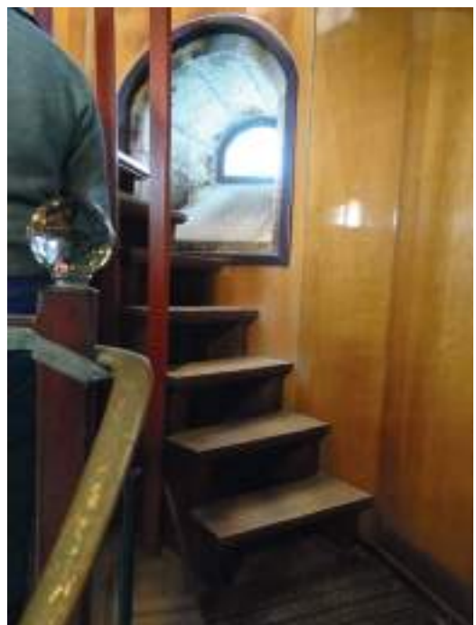
4- Accès au niveau supérieur, escalier bois, élévation habillée de placage bois
