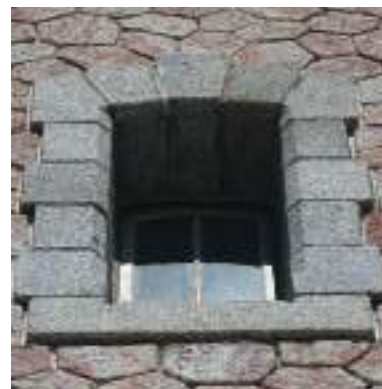
Détail d'une baie avec châssis en bois
