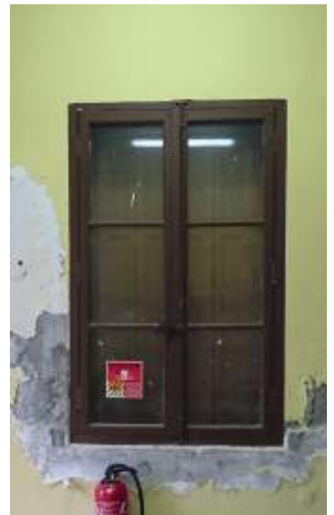
5- Vue intérieure d'une baie - Les châssis et volets semblent d'origine
