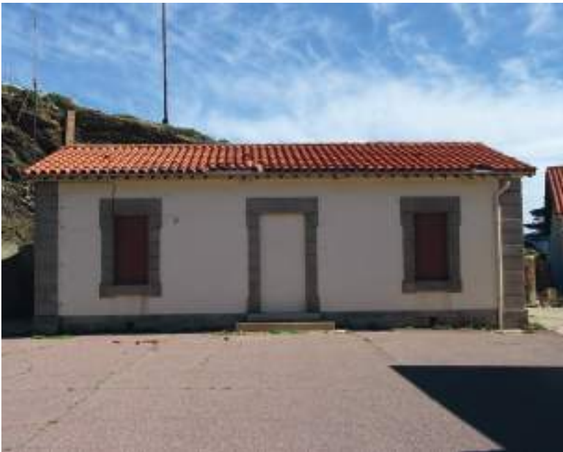
1- Élévation sur cour - bon état général, porte murée
