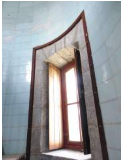
1- Détail d'une baie, châssis bois avec volet intérieur, ébrasements en granite et chambranle bois
